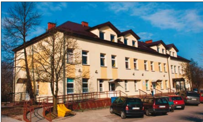
... i po modernizacji
