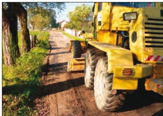
Gdy tylko pojawią się sprzyjające warunki atmosferyczne, rozpoczną się prace przy pozostałych inwestycjach, w większości będą to modernizacje dróg, ulic i chodników. W chwili obecnej rozstrzygane są kolejne przetargi na projekty przewidziane do realizacji w tym roku. Remont drogi w Strzemesznie
