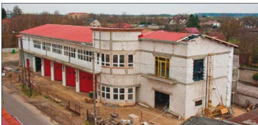
... i nowa siedziba Straży Pożarnej w Gąbinie na obecnym etapie robót
