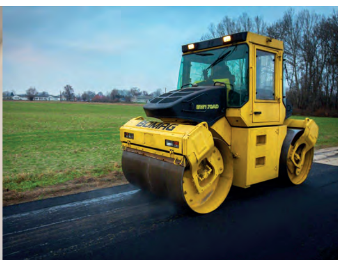
Modernizacja dróg gminnych
