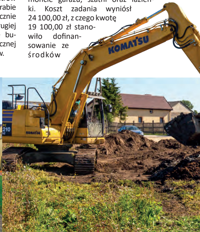
Renowacja stawu w Starym Kamieniu
