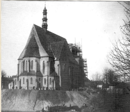
Świątynia w budowie, widok od strony skarpy
