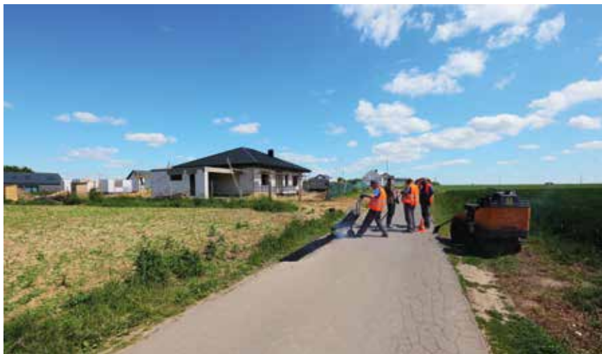
Prace drogowe na ul. Słonecznej w Gąbinie
