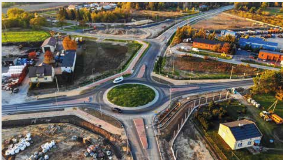
Prace przy miojejskiej obwodnicy
