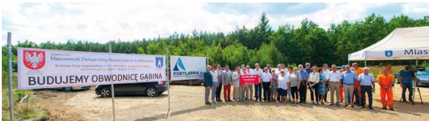
Rozpoczęcie budowy obwodnicy. 24 lipca 2018 rok
